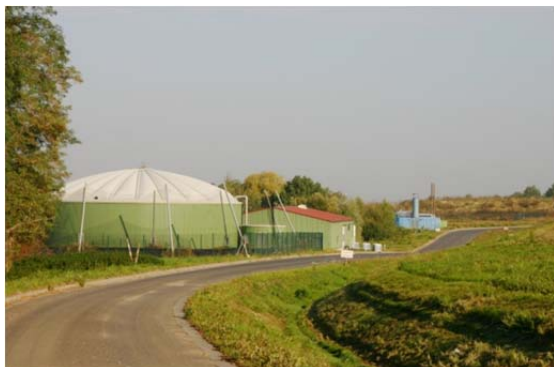
Deponie Gröbern: Sickerwasseraufbereitungsanlage und Blockheizkraftwerke
