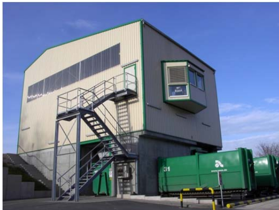
Umladestation Kleincotta mit angedockten Presscontainern
