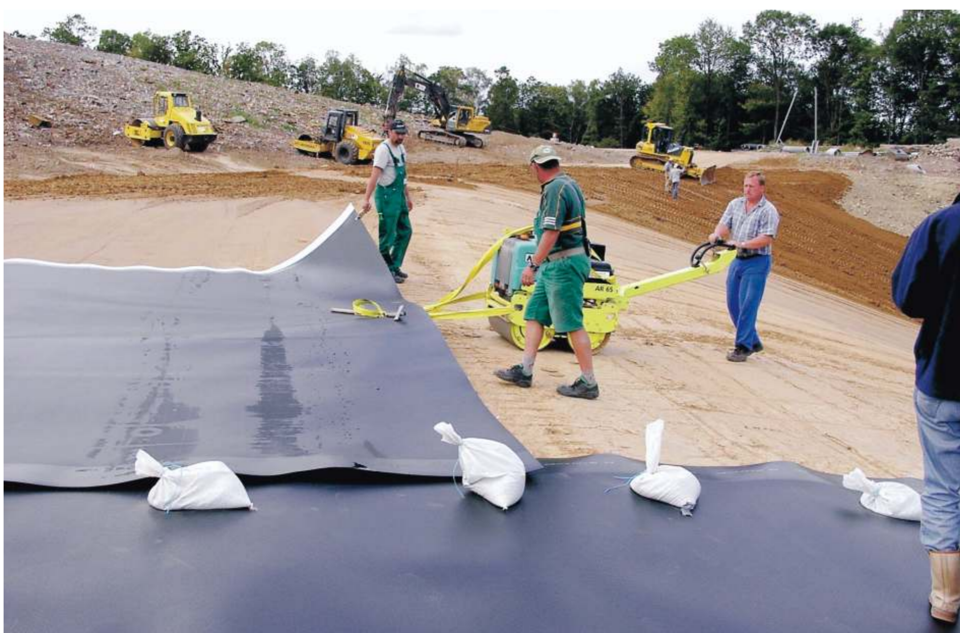
Endgültige Abdichtung oberer Teil Auslauffläche: Aufbringen einer 2,5 mm starken Kunststoff- dichtungsbahn
