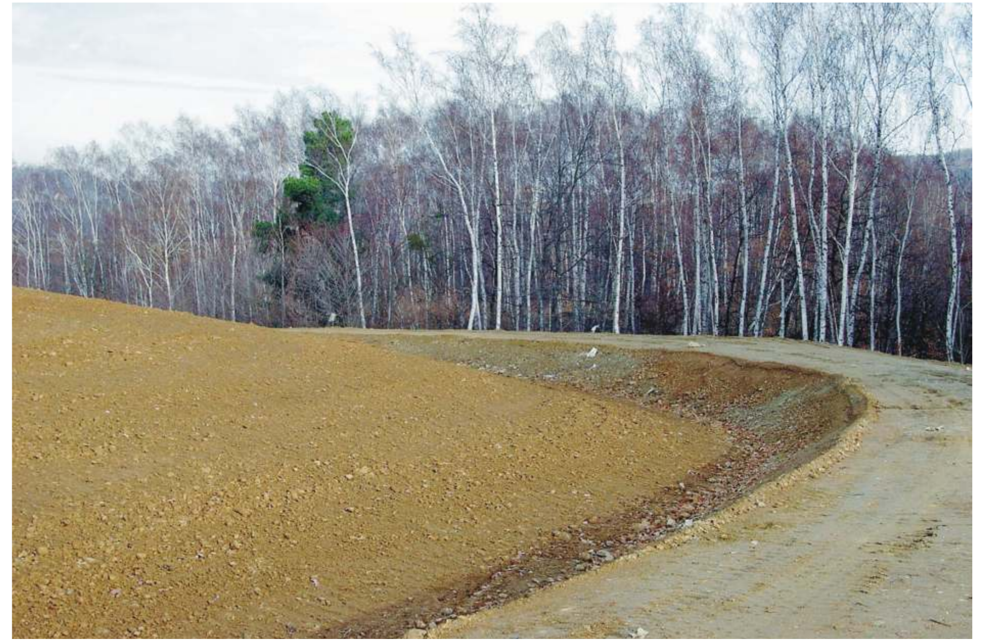
Temporär abgedichtetes kleines Restloch mit Rand- graben und Fahrstraße
