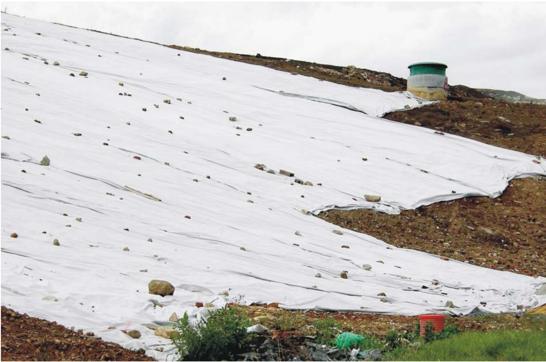
Aufbringen einer Schicht Trennvlies; darauf kommt die mineralische Dichtungsschicht
