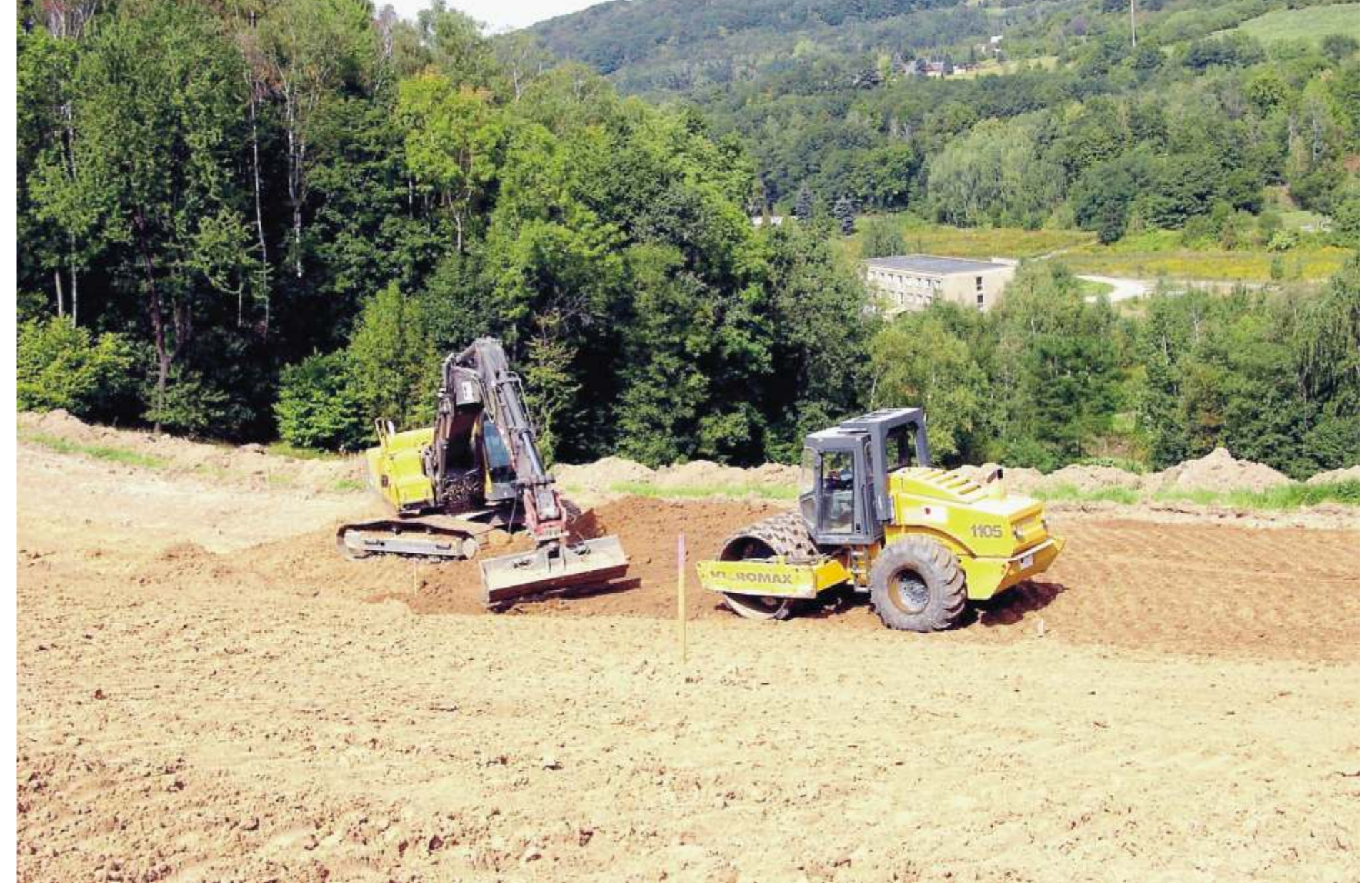
Beginn temporäre Abdeckung kleines Restloch: Aufbringen einer Ausgleichsschicht
