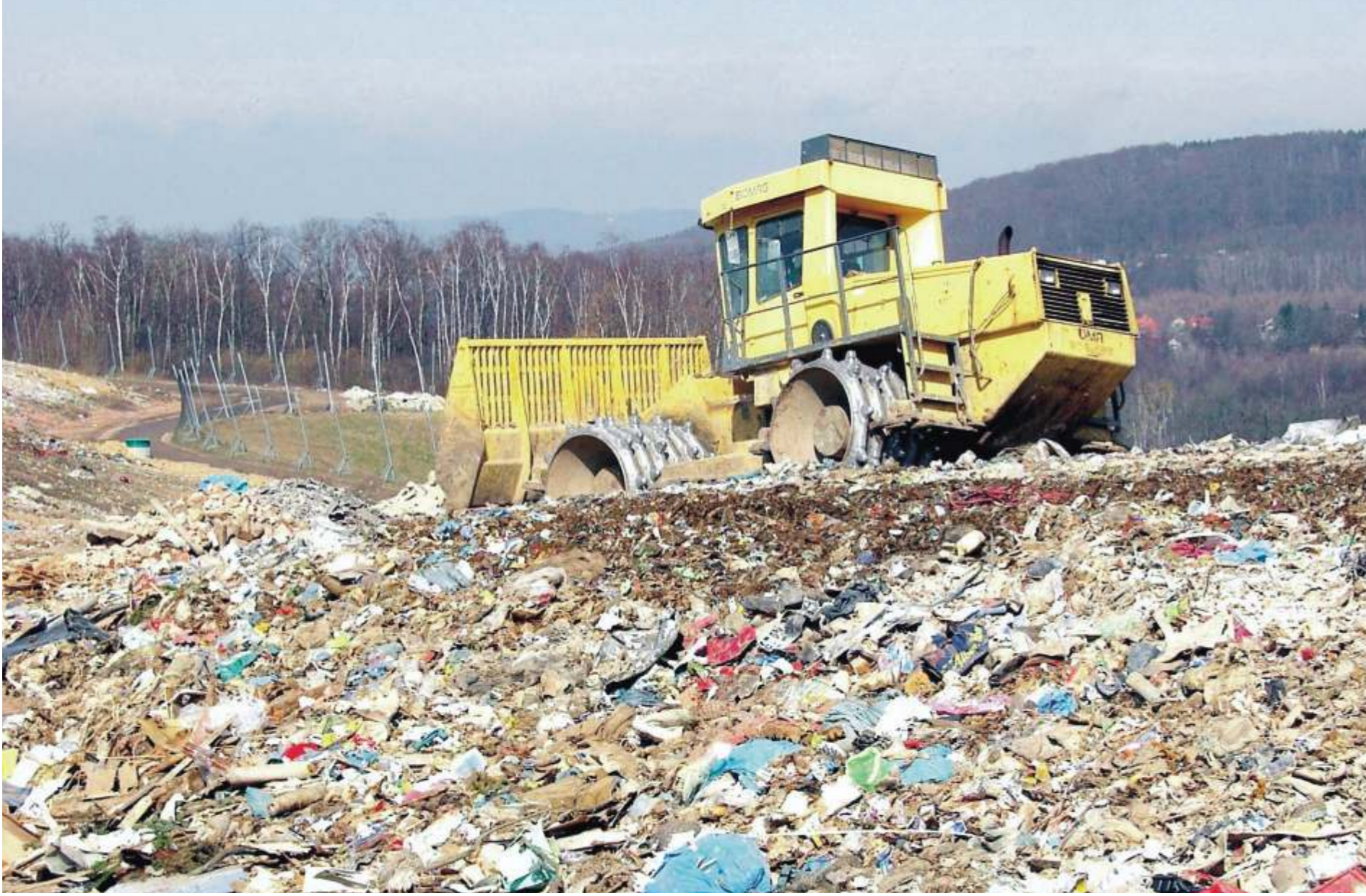
Vor der Sanierung: Kompaktor verdichtet den Restmüll
