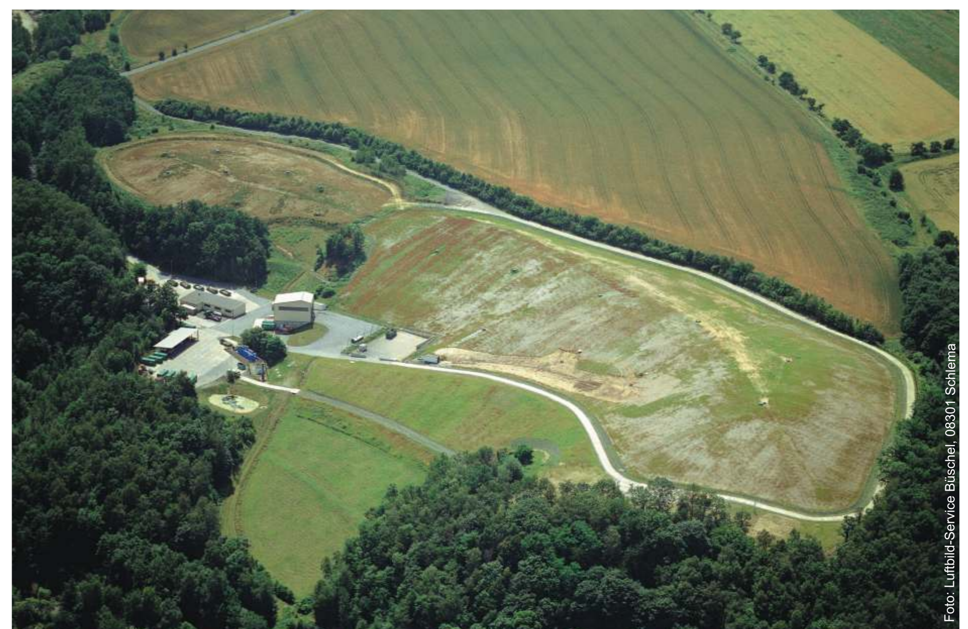
Deponie und Umladestation mit Kleinanlieferbereich Juni 2005 (li. hinten: kleines Restloch; re. hinten: großes Restloch; Mitte: Auslauffläche Richtung Bad Gottleuba
