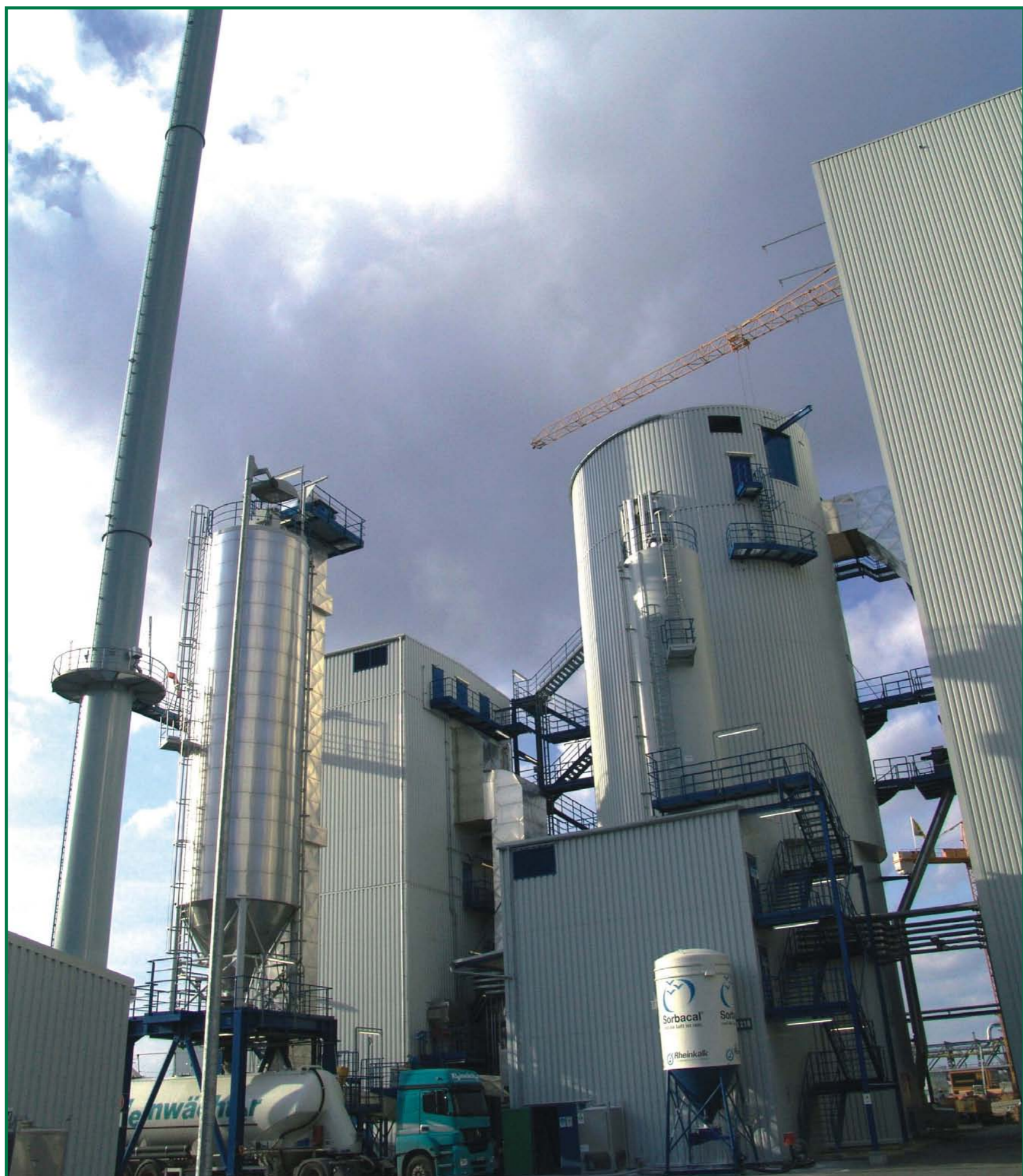
Rauchgasreinigungsanlage TREA Leuna
