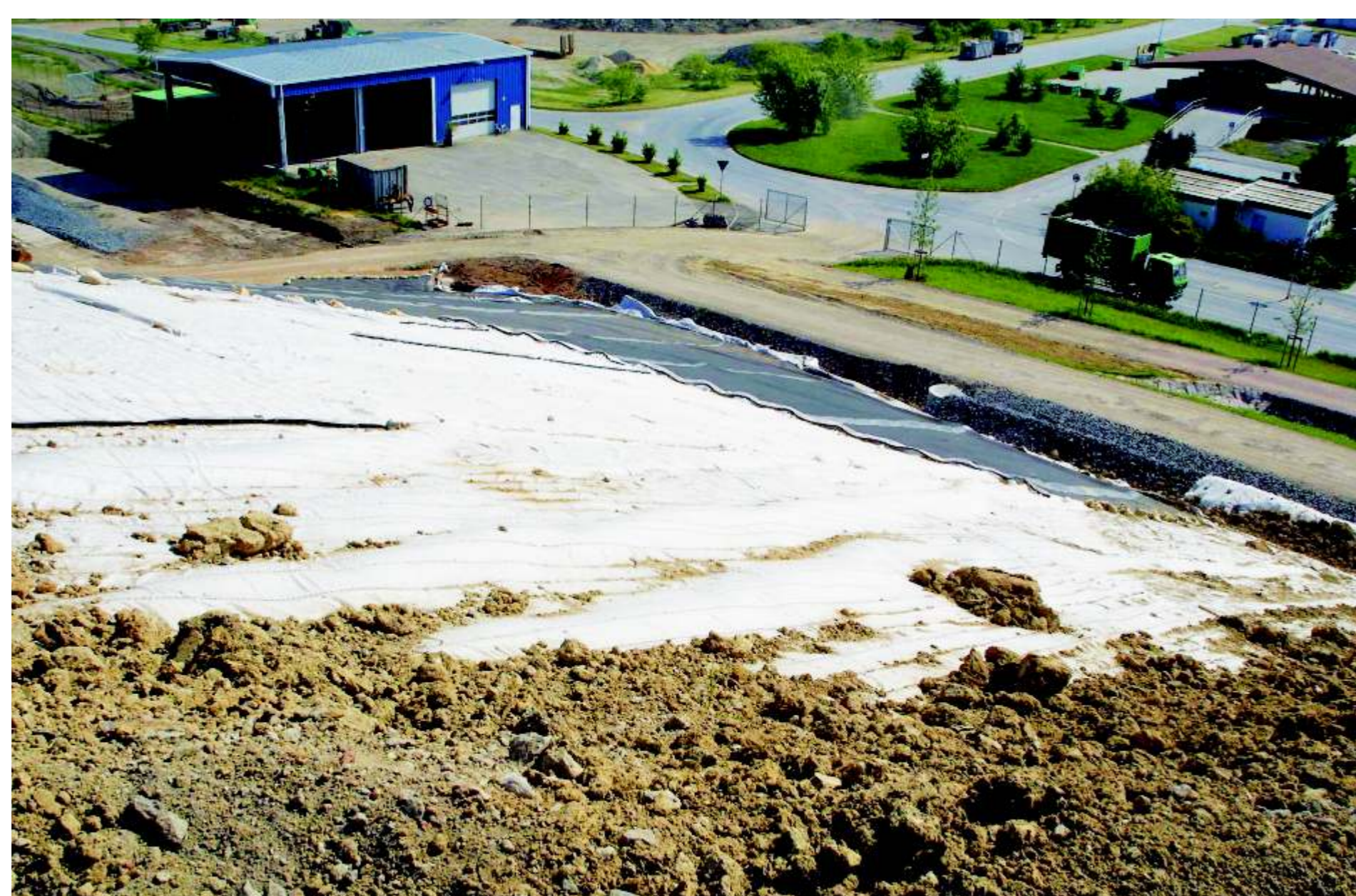
Aufbringen der Drainmatte, abschließend kommt Mutterboden darauf
