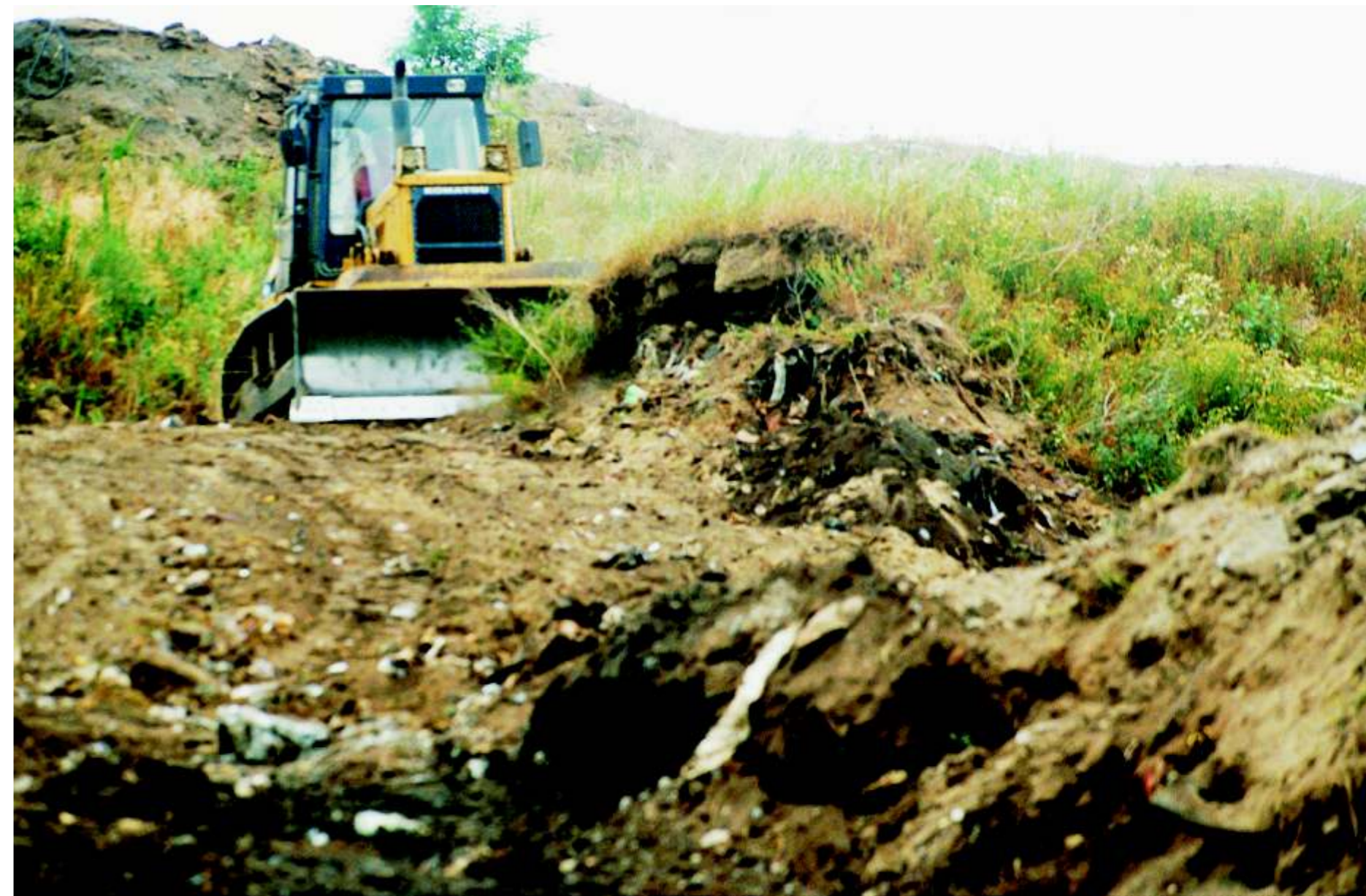
Beginn der Profilierungsarbeiten
