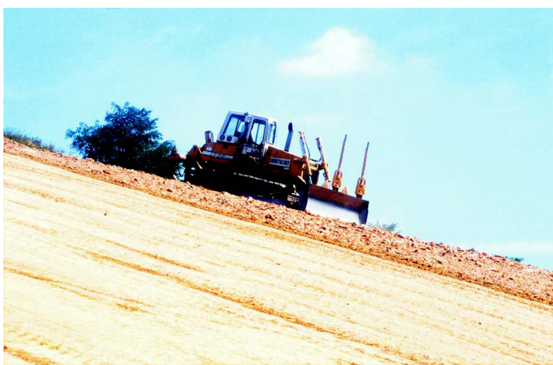
Einbau der mineralischen Dichtungsschicht
