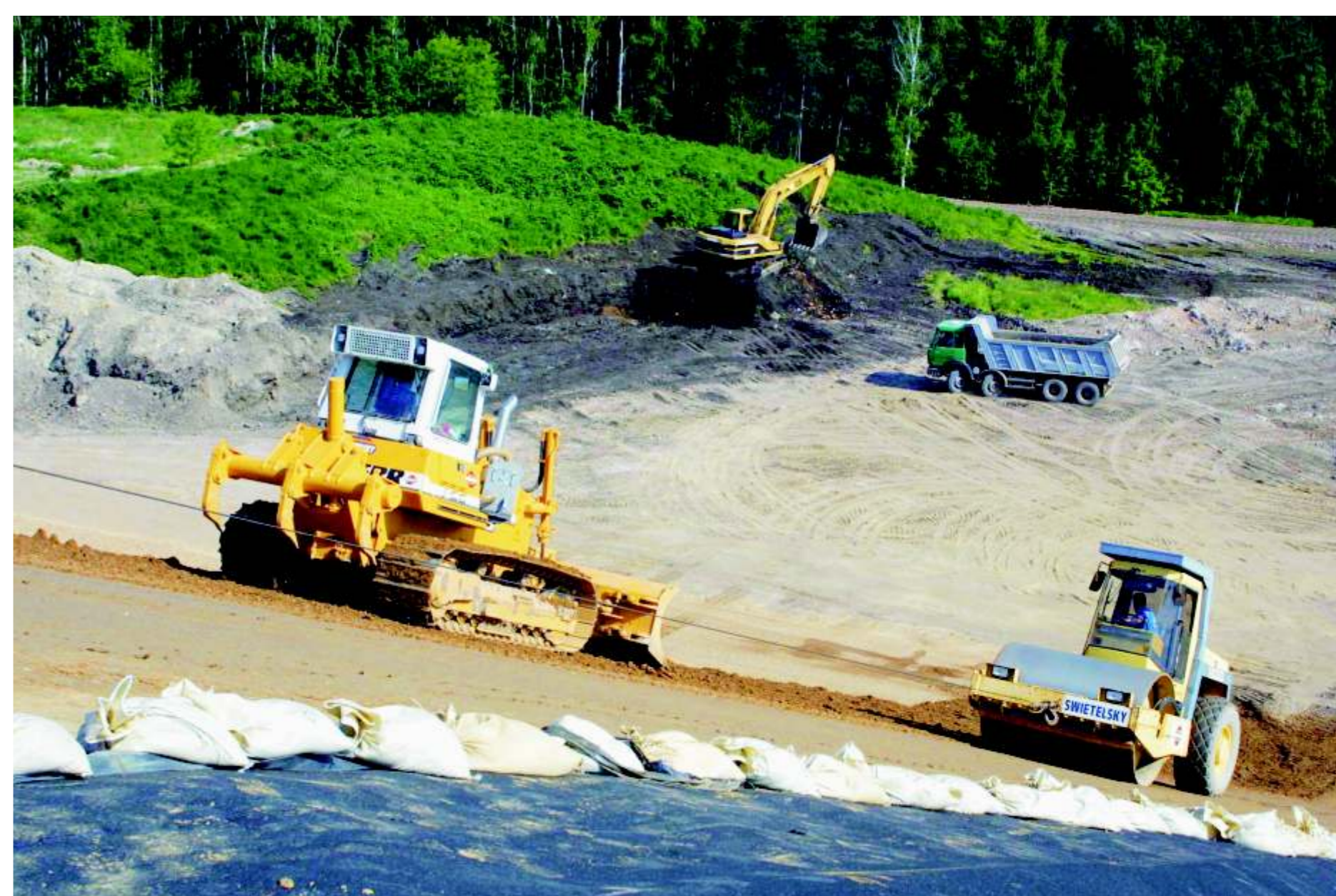
Verdichten der mineralischen Dichtungsschicht
